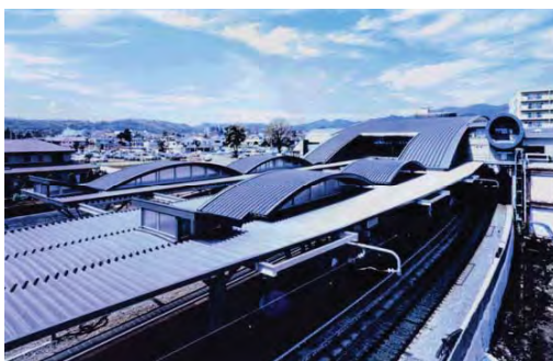
秦野駅自由通路橋上駅舎
