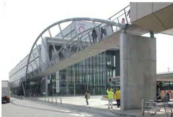
桜美林大学淵野辺駅キャンパス 淵野辺駅前歩道橋（新建築'03.06掲載）
